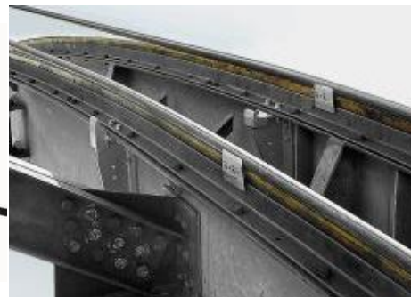
Slika 4: Dolžina premika nosilne vrvi in naleganje nosilnih vrvi na vrvni čevelj
